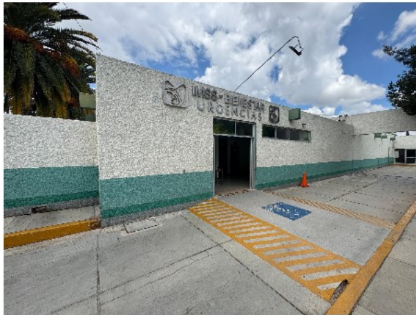
VISTA DE ACCESO A URGENCIAS
