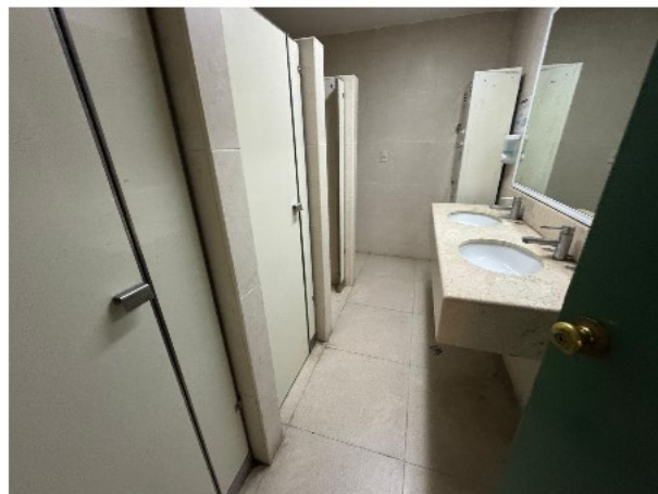
VISTA DE SANITARIOS
