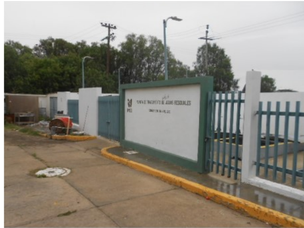
Planta Tratadora de aguas residuales
