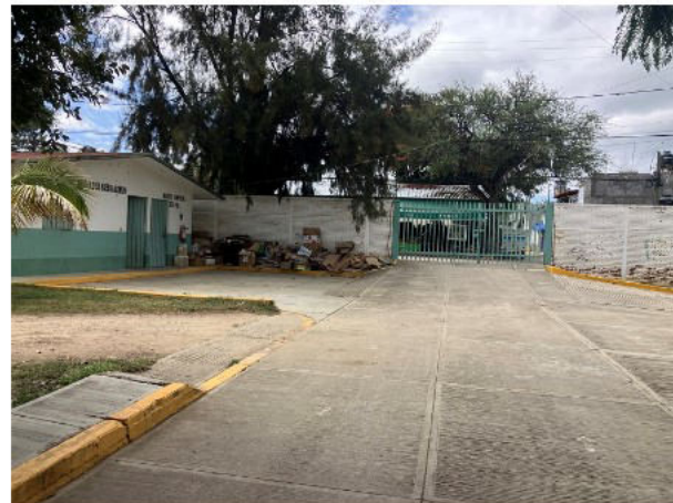
112.- ACCESO SOBRE LA CALLE LUIS BELTRAN
