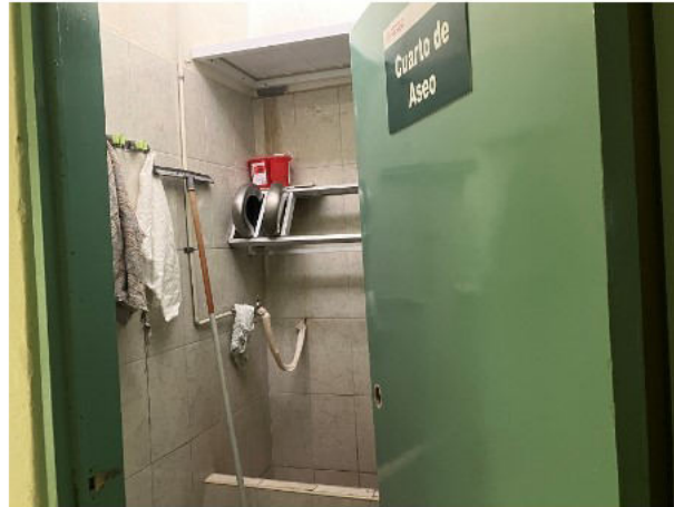
62.- VISTA DEL CUARTO DE ASEO. (HOSP.)
