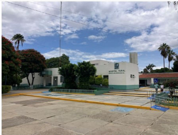
1.- VISTA DE LA FACHADA DEL ACTIVO.
