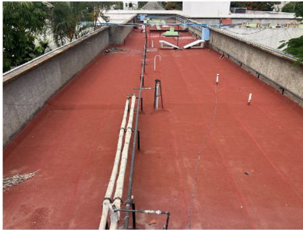
19.- VISTA DE LA AZOTEA. (ADMON)
