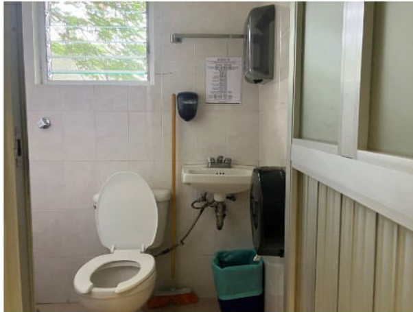
61.- . TOMA DEL SANITARIO EN PEDIATRIA. (HOSP.)
