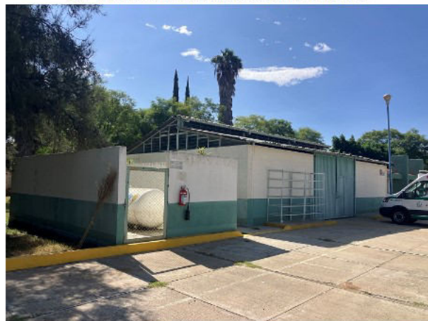
100.-FACHADA DE LA BODEGA Y TANQUE ESTACIONARIO.
