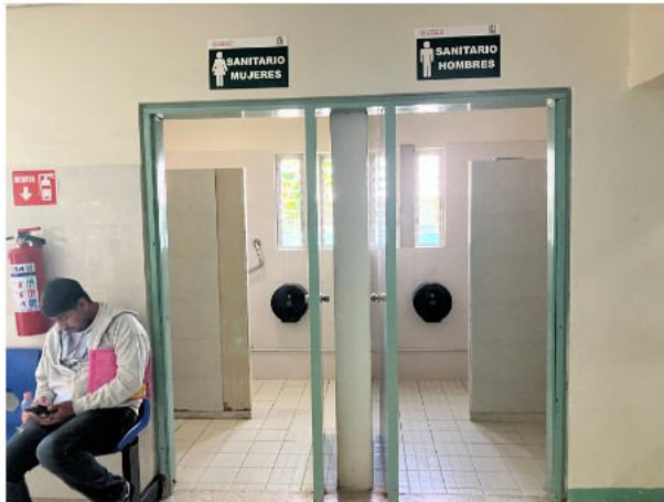
31.- ACCESO A LOS SANITARIOS.(C.E.)
