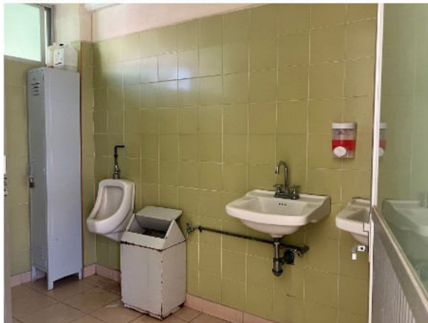
87.- TOMA DEL INTERIOR DE LOS SANITARIOS
