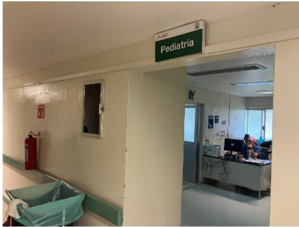
59.- TOMA DE ACCESO A PEDIATRIA. (HOSP.)
