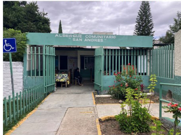
92.- FACHADA DEL ALBERGUE COMUNITARIO
