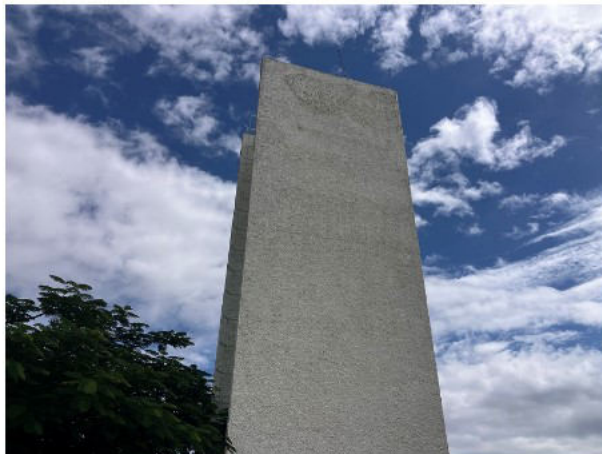
111.- VISTA DEL TANQUE DE AGUA
