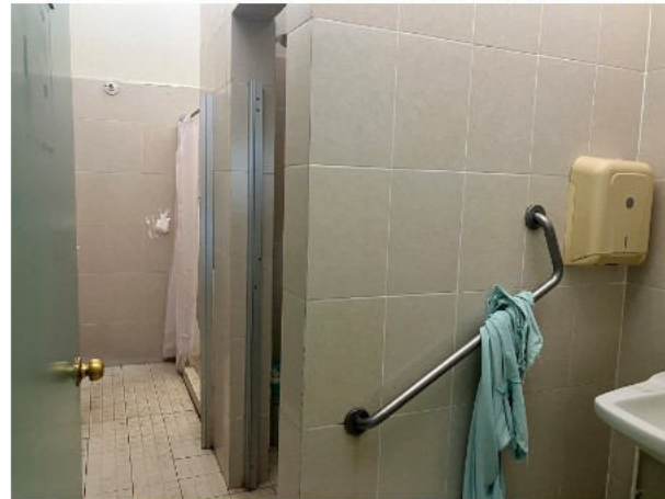
50.- INTERIOR DEL BAÑO DE MUJERES. (HOSP.)
