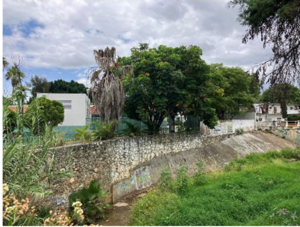
107.- VISTA DEL MURO DE CONTENCIÓN.
