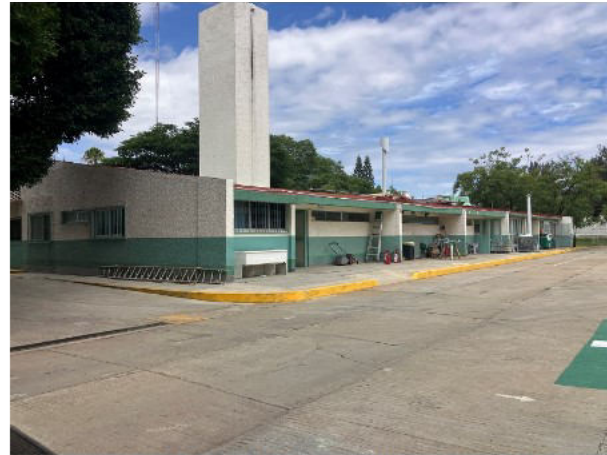
114.- TOMA DE LA PARTE POSTERIOR DEL IMSS.
