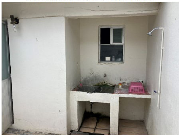
99.- AREA DE LAVADO EN ALBERGUE
