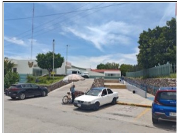
ZONA DE RAMPAS Y ACCESO AL HOSPITAL
