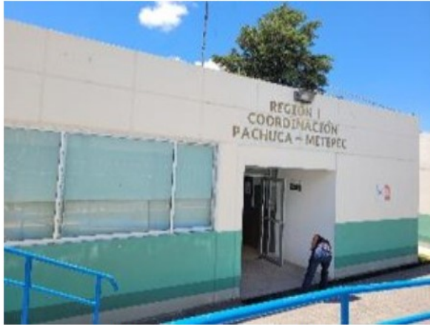
Vista general del activo en estudio.
