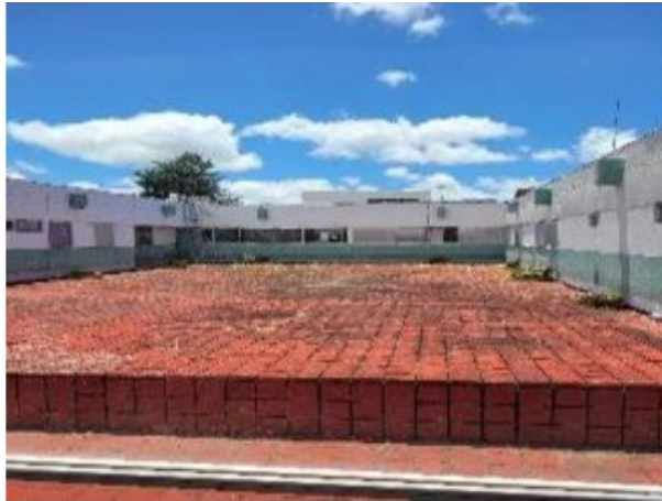
Vista general del activo en estudio.
