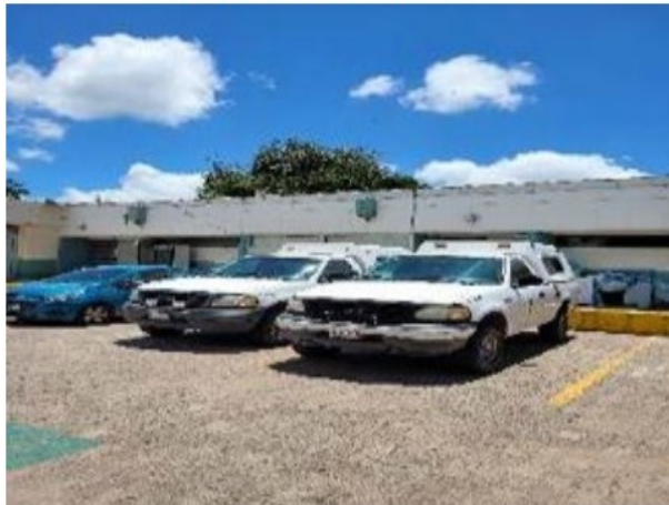
Vista general del activo en estudio.
