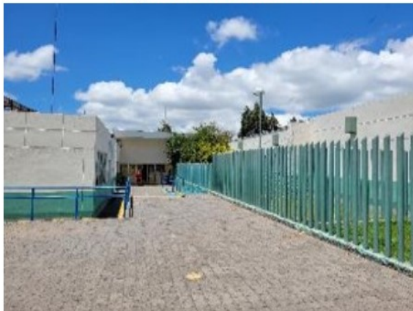
Vista general del activo en estudio.
