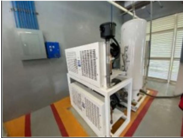
Casa de maquinas
