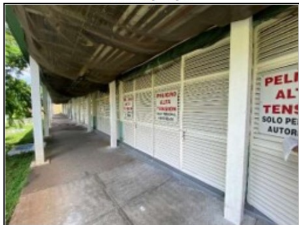
Exterior casa de maquinas
