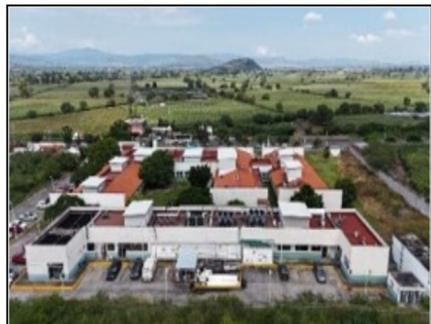
Vista aérea posterior del Hospital Rural Villamar IMSS - Bienestar
