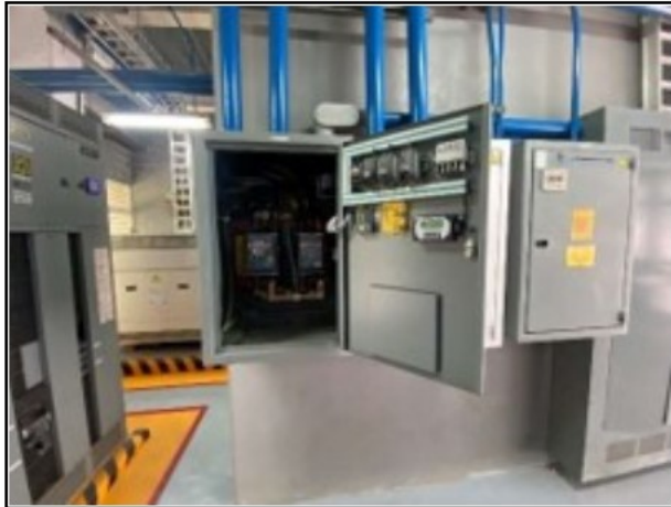
Casa de maquinas
