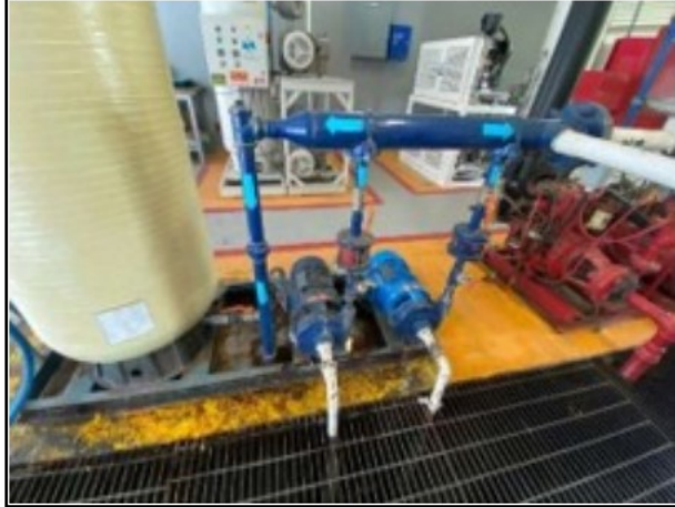
Casa de maquinas
