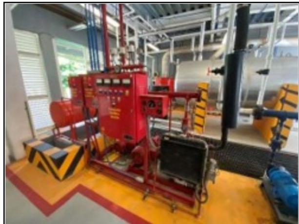
Casa de maquinas
