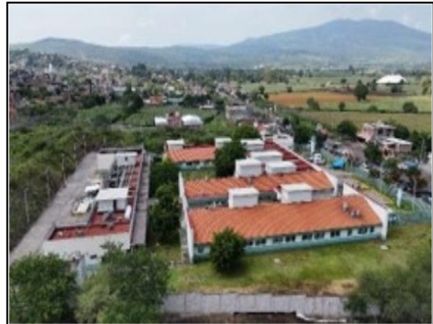
Vista aérea lateral del Hospital Rural Villamar IMSS - Bienestar
