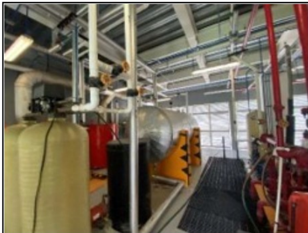
Casa de maquinas
