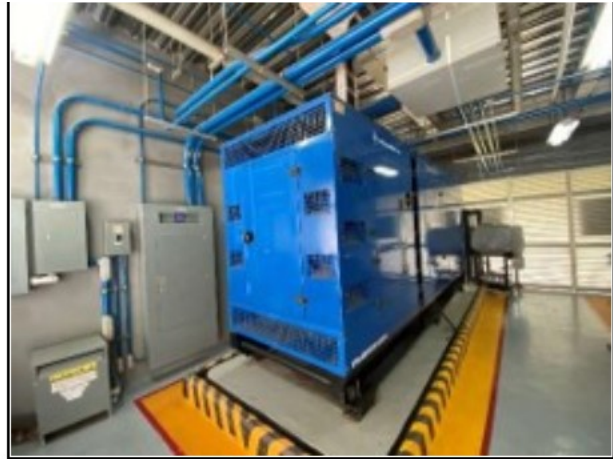
Casa de maquinas
