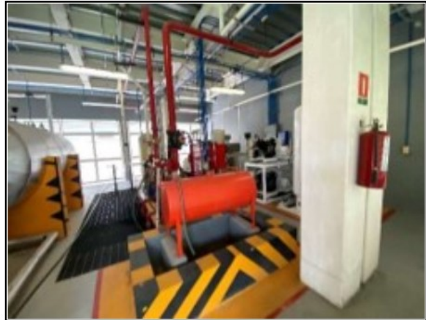
Casa de maquinas
