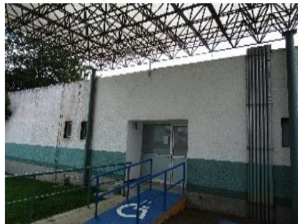
Vista general del activo en estudio.
