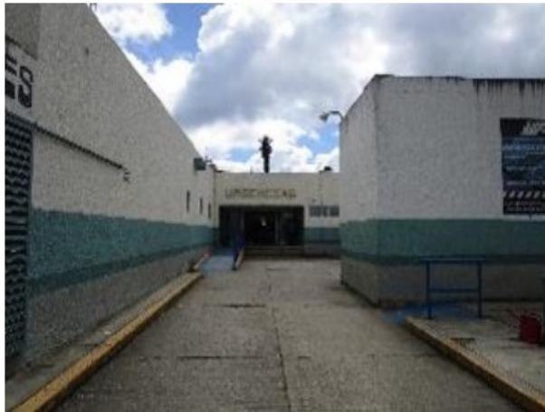
Vista interior del activo en estudio
