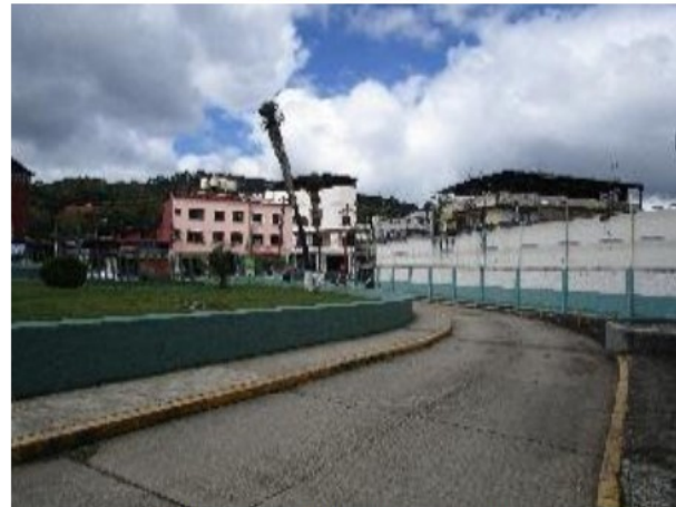
Vista general del activo en estudio.
