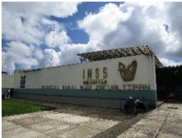
Vista de general de acceso al Activo en estudio.
