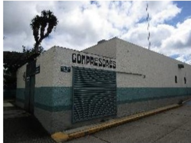
Vista de compresor
