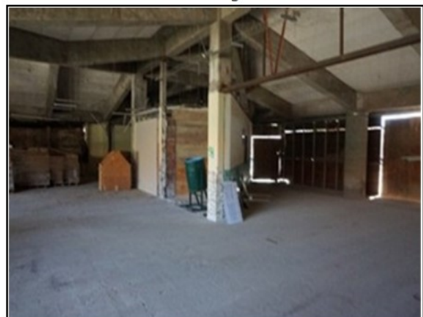
Área en proceso de remodelación
