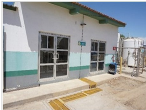
Cuartos de máquinas
