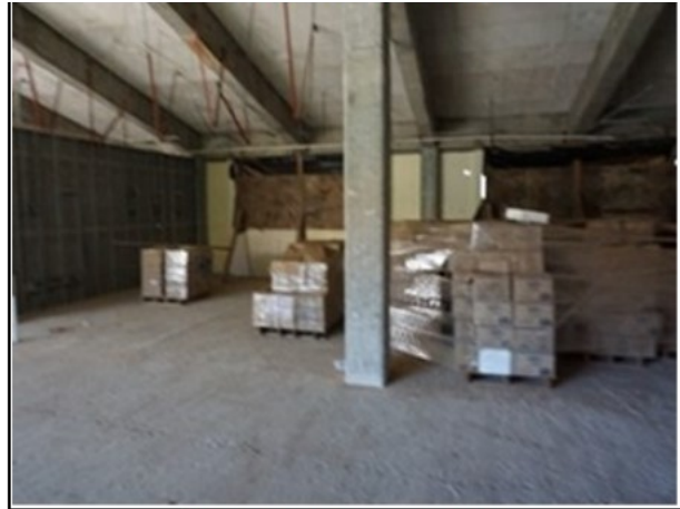
Área en proceso de remodelación
