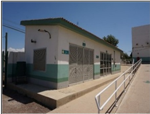
Cuartos de máquinas
