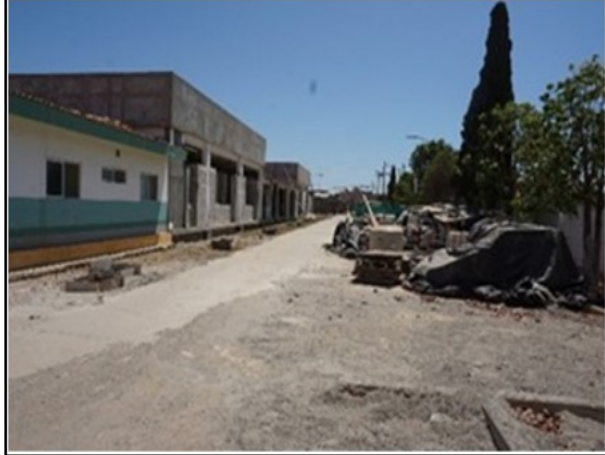
Área en proceso de remodelación
