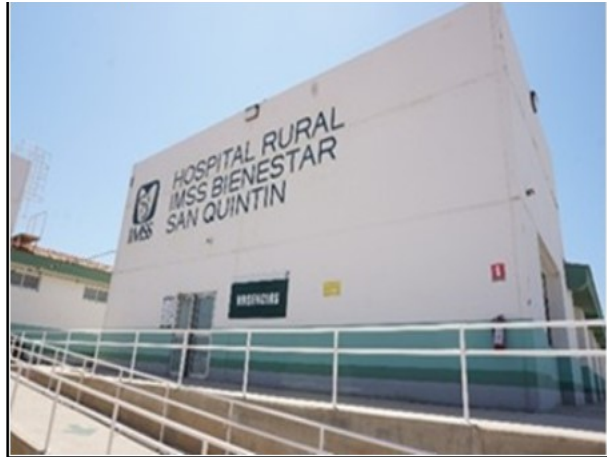
Área de urgencias
