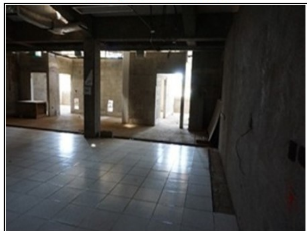
Área en proceso de remodelación
