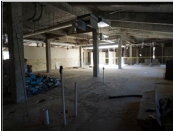
Área en proceso de remodelación
