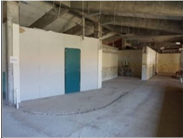
Área en proceso de remodelación
