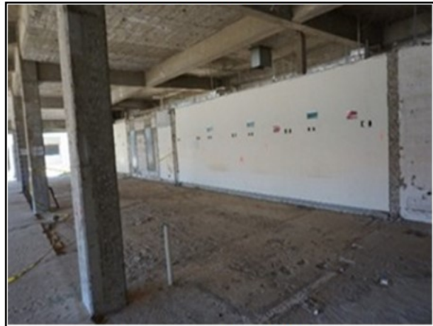
Área en proceso de remodelación
