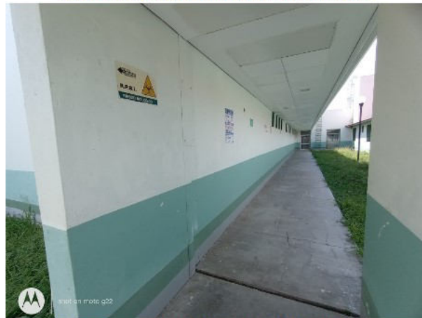
PASILLO CUBIERTO ENTRE EDIFICIO 3 Y 2.
