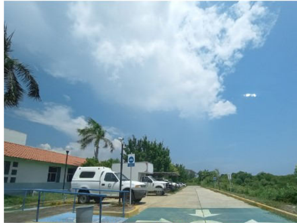
TECHUMBRE DE TEJA EN EDIFICIO 3, ESTACIONAMIENTO DESCUBIERTO Y VIALIDAD PERIMETRAL.
