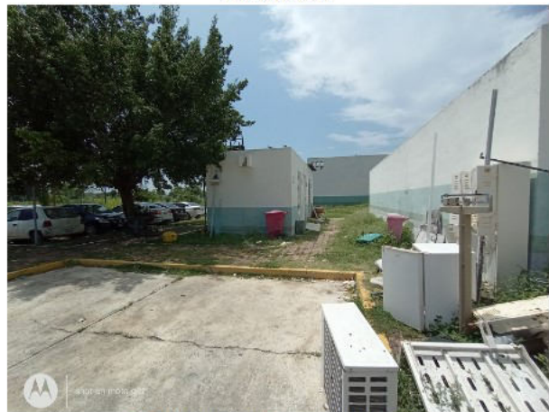
FACHADA SUROESTE EDIFICIO 1.
