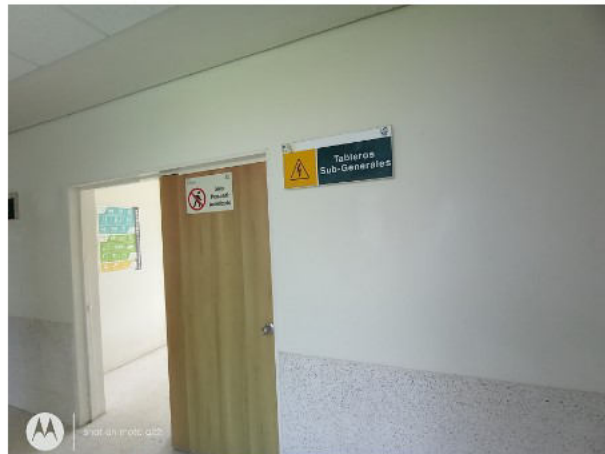
ÁREA TABLEROS SUB-GENERALES.
