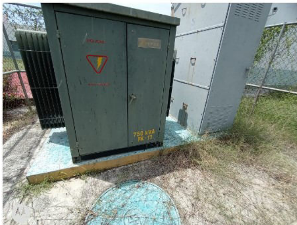
TRANSFORMADOR 750 KVA.
