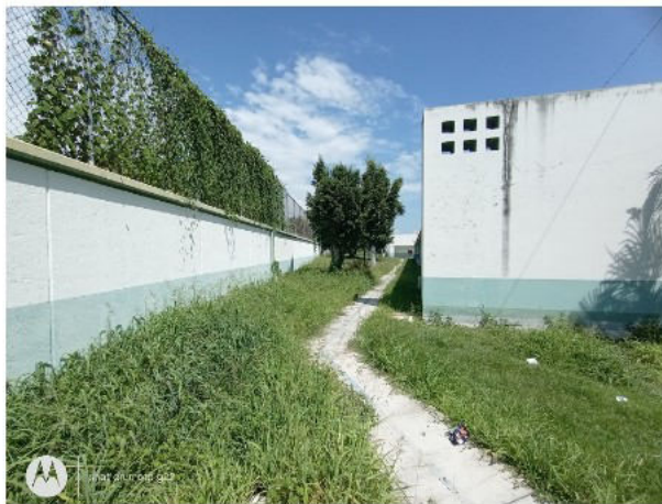
BARDA PERIMETRAL COLINDANCIA NORESTE.
