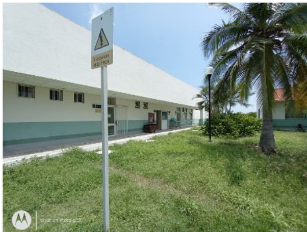
FACHADA NOROESTE EDIFICIO 1.
