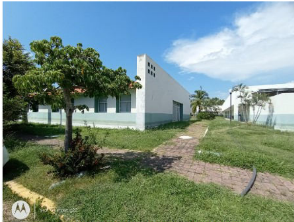
FACHADA SUR Y SURESTE EDIFICIO 3.
