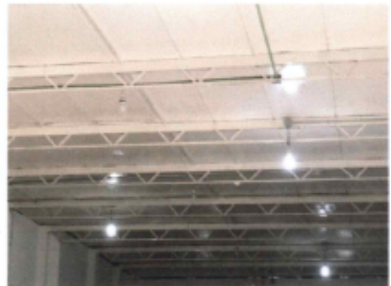
VISTA INTERIOR DE LA CUBIERTA
