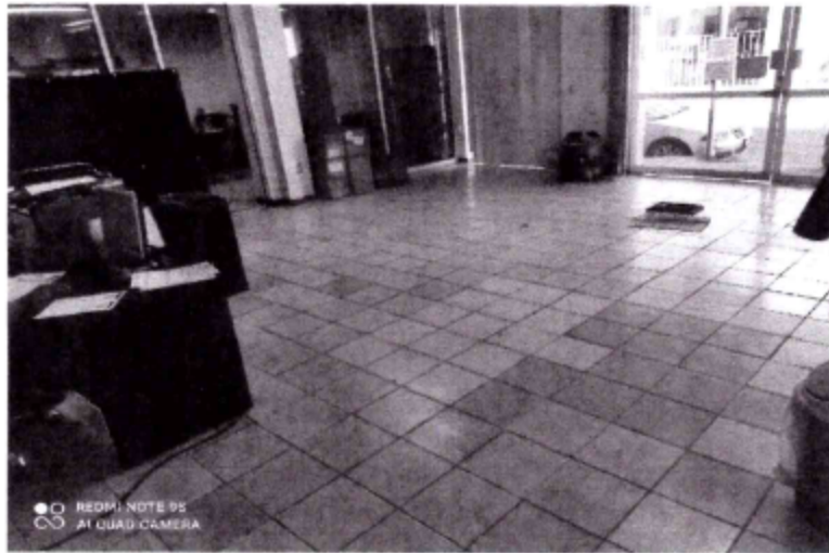
PISO EN BUEN ESTADO AREA COMUN
