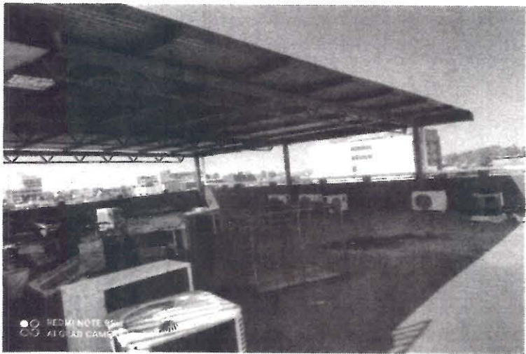
ESTRUCTURA METALICA EN PLANTA DE AZOTEA
