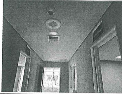
FOTO No. 1: COLOCACIÓN DE SEÑALIZACIÓN FOTOGRAFIA TOMADA EL DIA 30 DE JUNIO DE 2026
