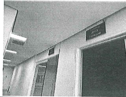
FOTO No. 2: COLOCACIÓN DE SEÑALIZACIÓN FOTOGRAFIA TOMADA EL DIA 30 DE JUNIO DE 2026
