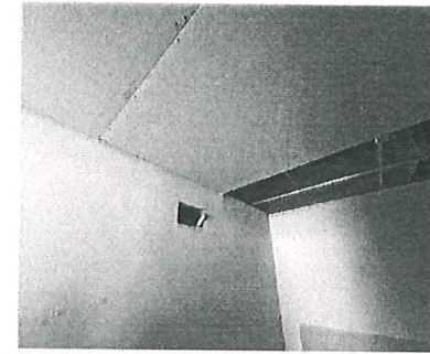
FOTO No. 6: PREPARACIÓN EQUIPO DE MINISPLIT ÁREA DE MASTÓGRAFO FOTOGRAFIA TOMADA EL DIA 30 DE JUNIO DE 2026
