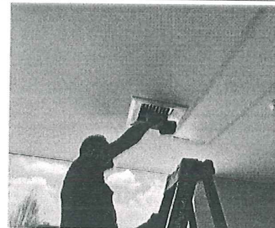
FOTO No. 9: COLOCACIÓN DE REJILLAS CON CONTROL DE VOLUMEN FOTOGRAFIA TOMADA EL 30 DE JUNIO DE 2026
