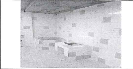
FOTO No. 1: DESCRIPCIÓN DE FOTOGRAFÍA.- SUMINISTRO E INSTALACION DE AZULEJO EN AREA DE ESFINTERES ESTA FOTOGRAFIA FUE TOMADA EL DIA.- 17 DE NOVIEMBRE 2022.
