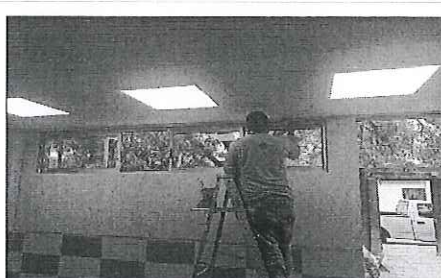
FOTO No. 8: DESCRIPCIÓN FOTOGRAFICA.- SUMINISTRO E INSTALACION DE PINTURA VINILICA EN AULA DE MATERNALES ESTA FOTOGRAFIA FUE TOMADA EL DIA 29 DE NOVIEMBRE 2022.
