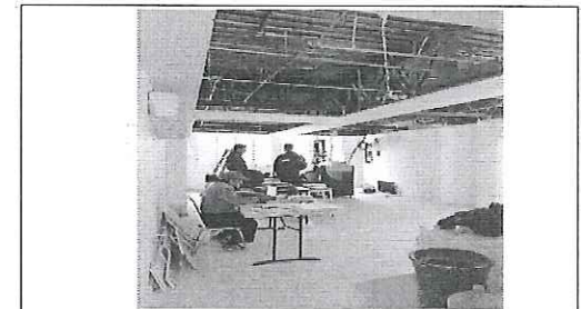
FOTO No. 9: DESCRIPCIÓN FOTOGRAFICA.- FABRICACION DE PLATA BANDA EN PLAFON DE TABLAROCA DEL AREA DE GOBIERNO. FOTOGRAFIA TOMADA EL DIA 30 DE NOVIEMBRE DE 2022
