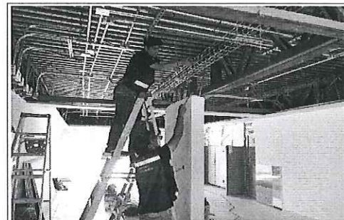
FOTO No. 8: TRABAJOS DE CANALIZACION DE VOZ Y DATOS DEL AREA DE GOBIERNO.
