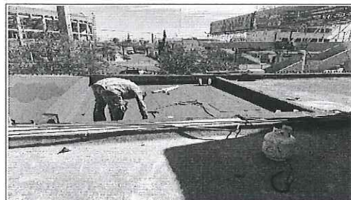
FOTO No. 7: TRABAJOS DE IMPERMEABILIZACION EN AREA DE GOBIERNO.
