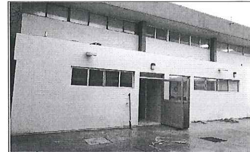
FOTO No. 3 TRABAJOS DE CIERRE DE DETALLES Y LIMPIEZA DE MATERNALES
