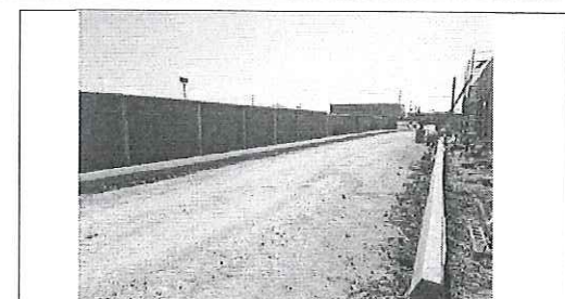
FOTO No. 3 COLOCACION DE CORDONES DE BANQUETAS FOTOGRAFIA TOMADA EL DIA 29 DE SEPTIEMBRE 2023
