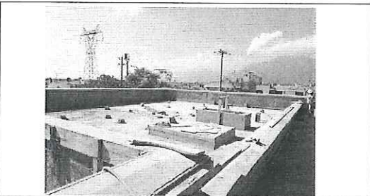
FOTO No. 7: COLADO DE PRELILES ESTA FOTOGRAFIA FUE TOMADA EL DIA 28 DE SEPTIEMBRE 2023.
